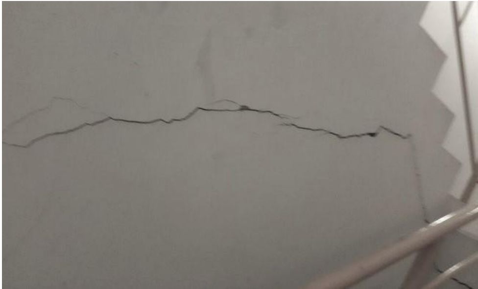
Figura 10. Fisura en la estructura del edificio a consecuencia del evento Chileno. Fuente: Diario Digital Última Hora.
