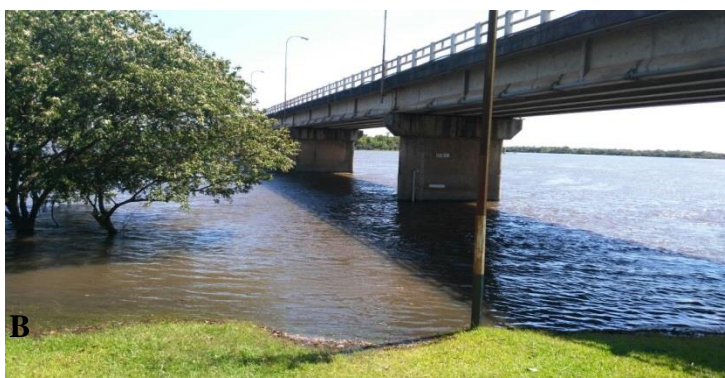
Foto tomada a la izquierda del puente Villa Florida localidad Manga Ita. Se observa el ascenso del nivel de las aguas del Río Tebicuary, luego de las intensas precipitaciones.
